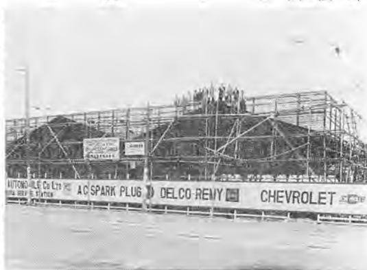
建築中のヤナセ・サービス工場
