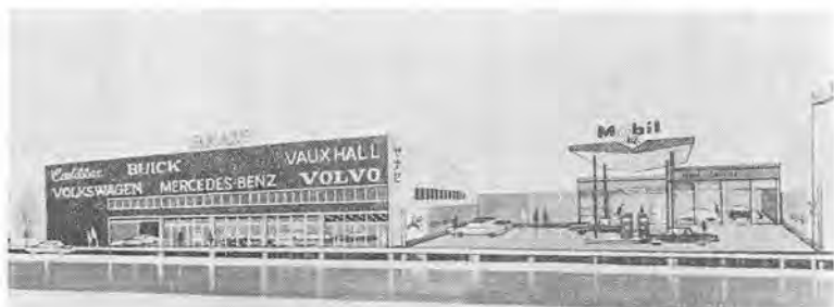
昭和41年10月1日、名古屋支店の新社屋完成
