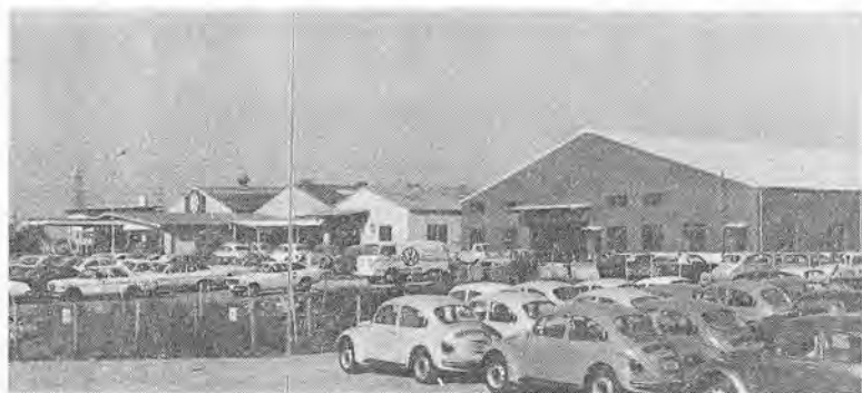
昭和48年12月、名古屋デポー新工場竣工
