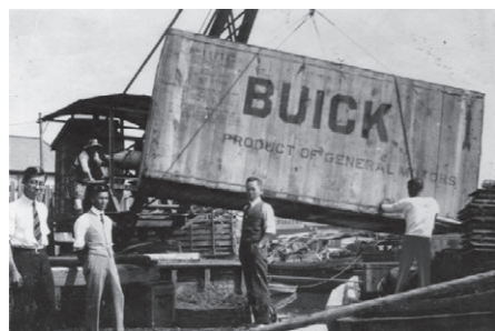
1923（大正12）年、芝浦工場に陸揚げされるビュイック。輸入車の輸入は、体積を小さくするためパーツごとに分解され輸入されていた。リムジン型の完成車は一台ずつ箱詰めされていたが、ボディは当社で製作取り付けを行った
