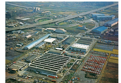
横浜デポ周辺(手前の大きな工場は製造事業部小机工場)
