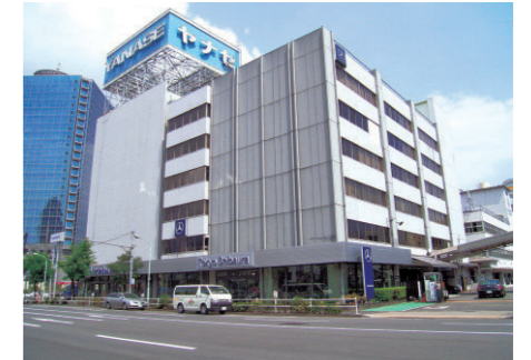
ヤナセビル新館(手前)と芝浦会館
