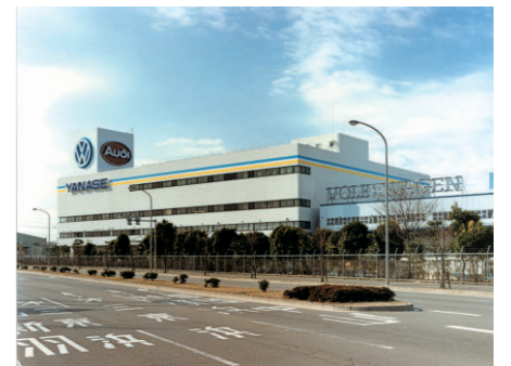
1986（昭和61）年に完成したパーツ倉庫
