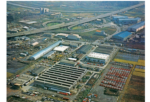
横浜デポ周辺(手前の大きな工場は製造事業部小机工場)
