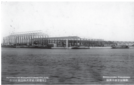
建築中のフォード横浜工場
