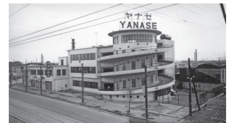
大阪支店のシンボルだったスパイラルランプのある新工場は1961(昭和36)年に完成
