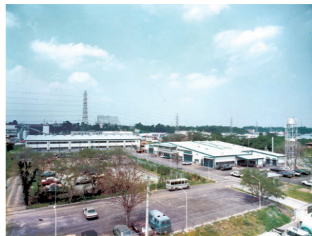
横浜ニューデポ竣工
