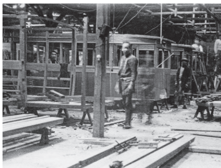
永楽町分工場における東京市街自動車のボディ製作
