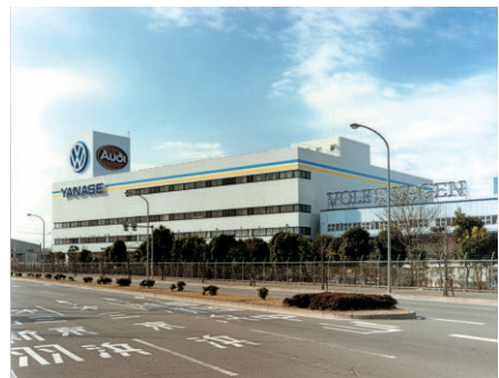
1986（昭和61）年に完成したパーツ倉庫
