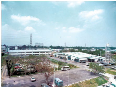
横浜ニューデポ竣工
