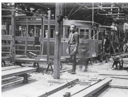
永楽町分工場における東京市街自動車のボディ製作
