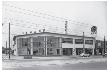
1954(昭和29)年に完成した大阪支店
