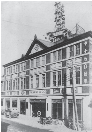
呉服橋本社。屋上の広告塔が、自動車の形に作られている
