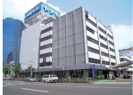
ヤナセビル新館（手前）と芝浦会館
