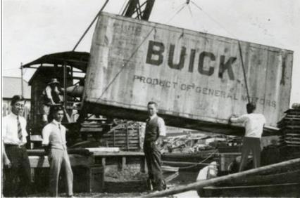
1923（大正12）年、芝浦工場に陸揚げされるビュイック。輸入車は体積を小さくするために、パーツごとに分解して輸入されていた。リムジン型の完成車は一台ずつ箱詰めされていたが、ボディは当社で製作取り付けを行った。
