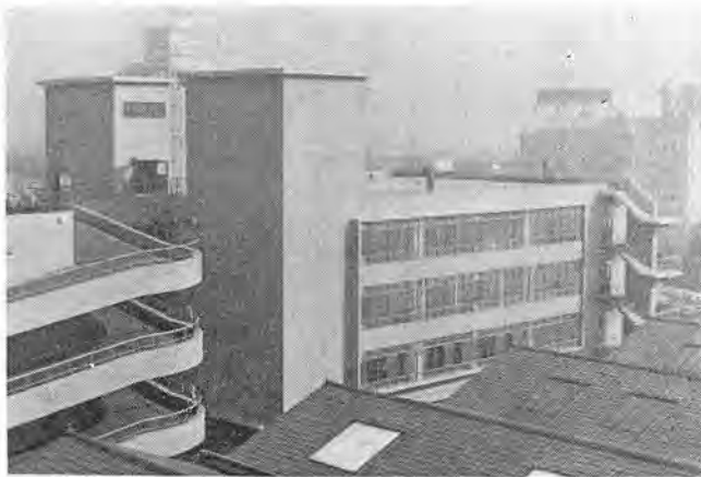
昭和41年1月、芝浦に完成したウエスタン第3工場
