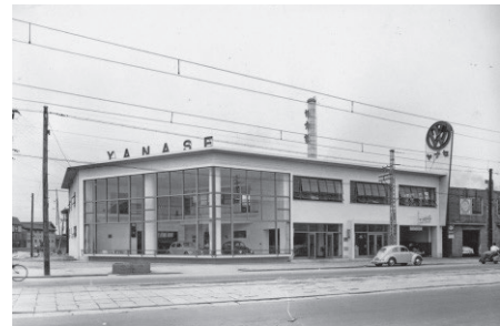
1954(昭和29)年に完成した大阪支店
