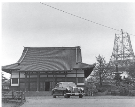
建設中の東京タワーとメルセデス・ベンツ
